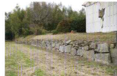
土塁基底部の石垣 (本丸「辰巳角之御櫓」付近)
